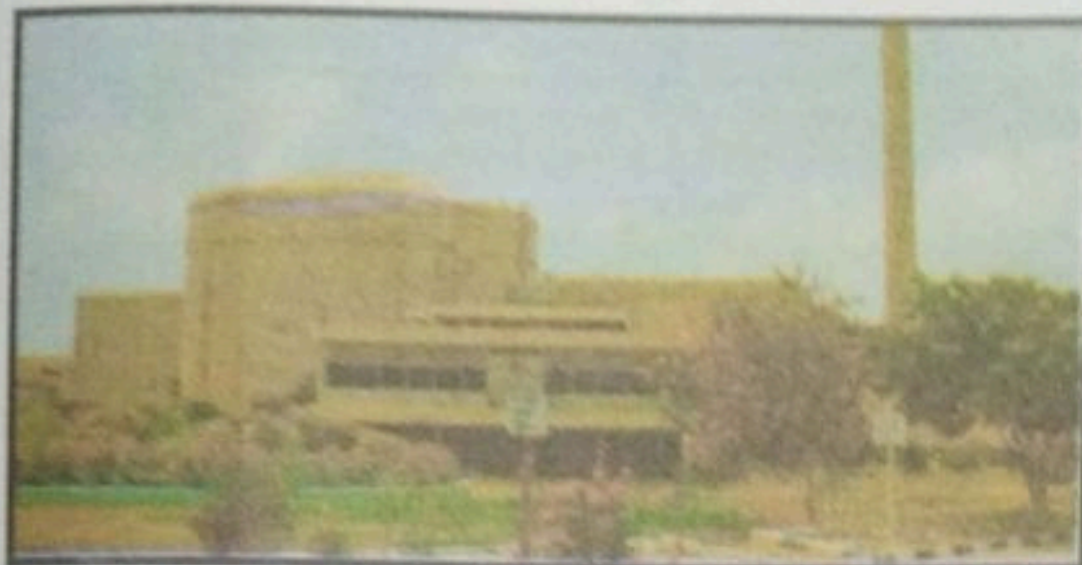
b. Karachi Nuclear Power Plant (KANUPP)
